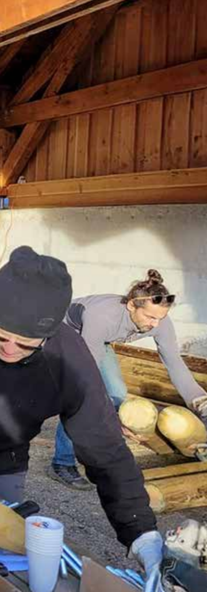
L'une des dernières réalisations du mandat : la construction à Pomarey des barrières pour la chicane de Moretière.
