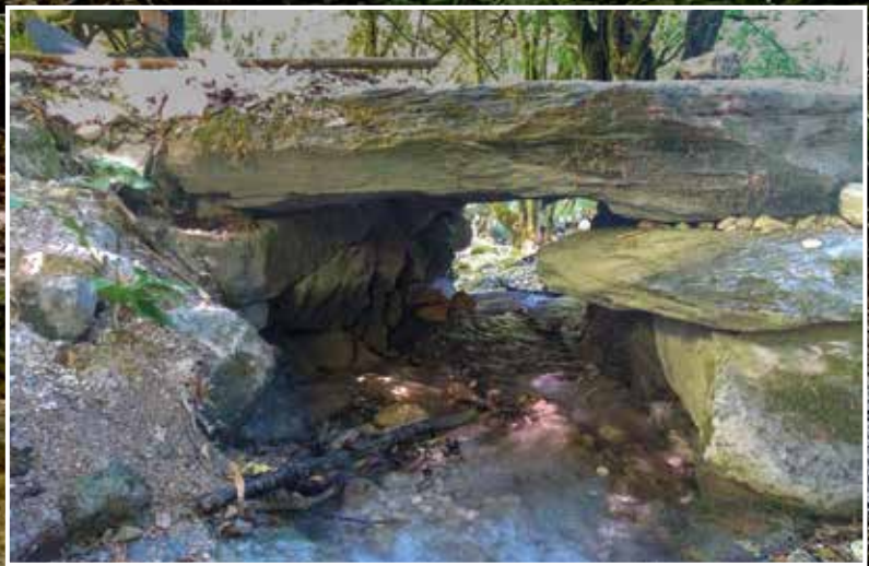
Le pont de la Buissière après sa restauration.
